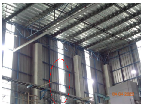
ภาพที่ 2.2-34 การติดตั้งระบบป้องกันไฟฟ้าสถิต
